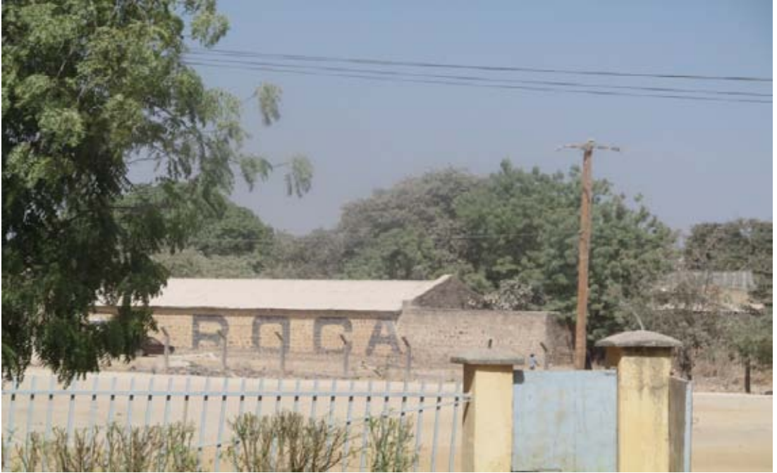
Batiment des Etablissements CHAUX ROCA à Figuil (Photo Jaff BAMENJO)
